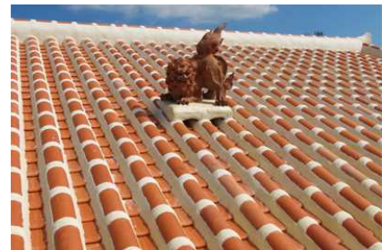
沖縄県の漆喰の瓦屋根
