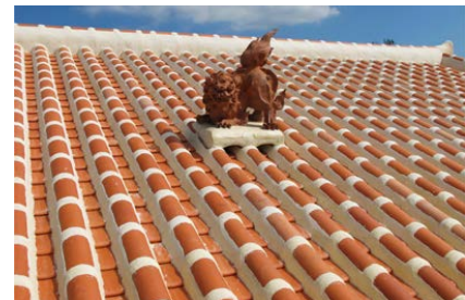
沖縄県の漆喰の瓦屋根
