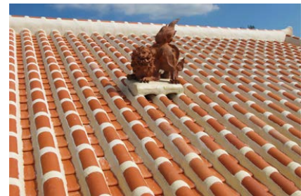
沖縄県の漆喰の瓦屋根
