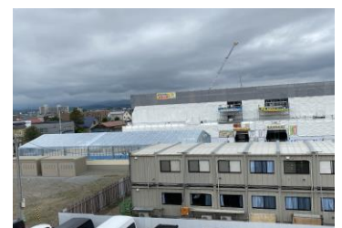
新校舎の作業は進んでいます
